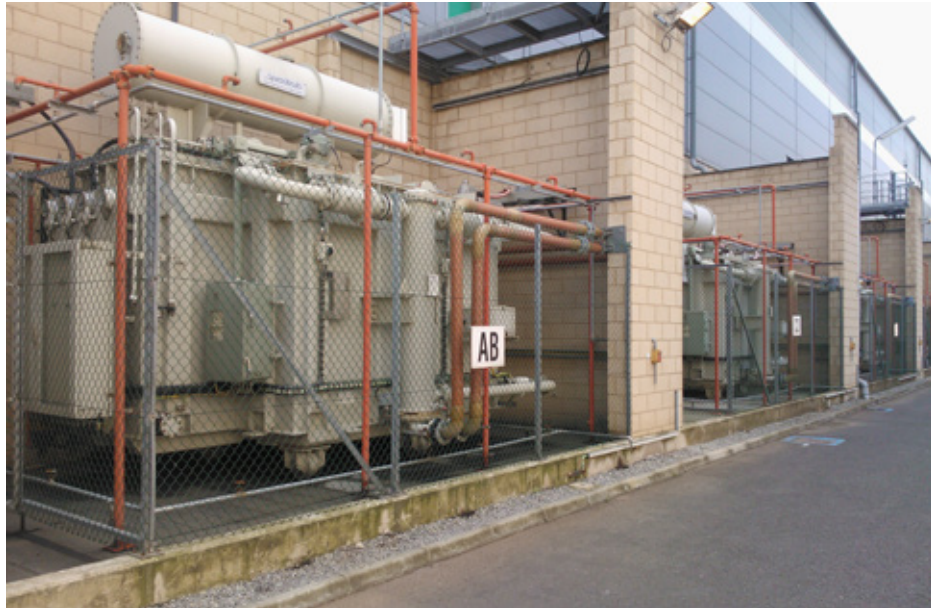
Abbildung 3.4 – Die Transformatorenbuchten
